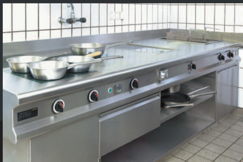
Die Silvretta Nova-Gruppe vertraut seit Jahren auf Menu System-Induktionstechnik – hier die Herdanlage der Casa Nova an der Talstation der Valiserabahn.
