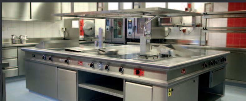
Induktionsherdanlage im Schloss Fuschl: kompromisslose Qualität.
